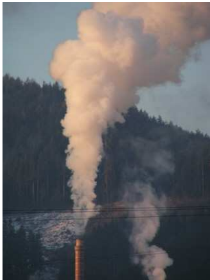
Biomassekraftwerk für Feuchthackgut
